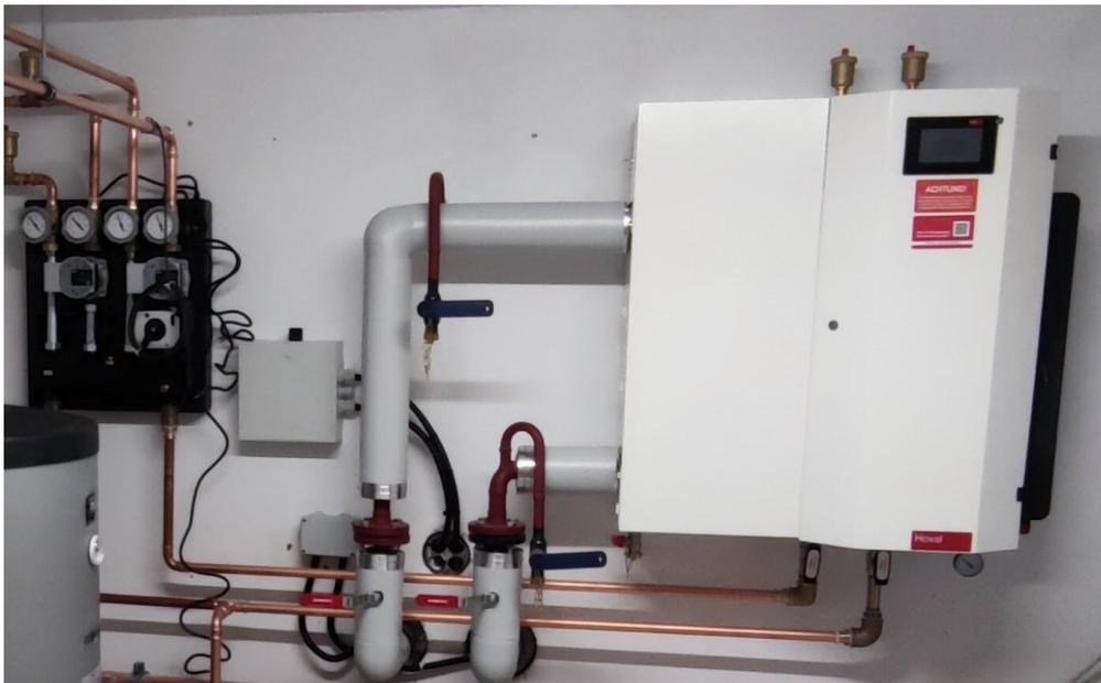
🎯 Wir benötigen jetzt sogar weniger Heizleistung (genaue Verbrauchsdaten wird es erst nach Ablauf eines Jahres geben). Auch die Vorlauftemperatur pendelt sich zwischen 30 und 35°C ein, sodass der Betrieb mit den „alten“ Radiatoren kein Problem darstellt.
